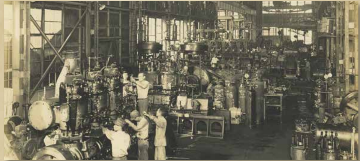
エンジン運転準備作業(手前焼玉エンジン、奥ディーゼルエンジン)旧神戸工場 試運転工場 1939(昭和14)年頃
