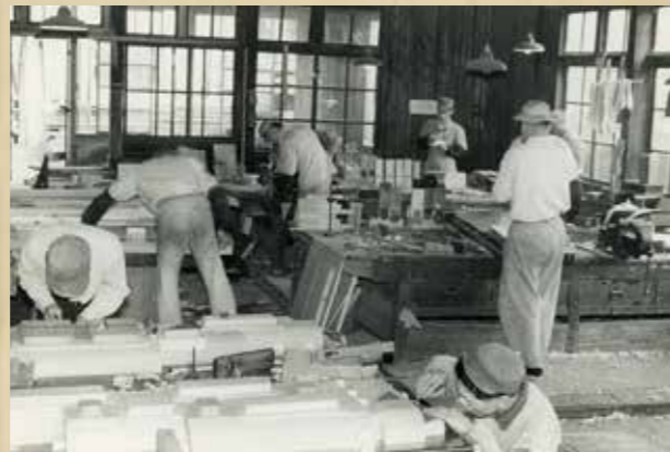
木型製作作業 旧神戸本社工場 木型工場 昭和30年代前半
