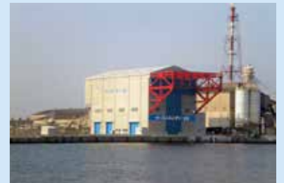
200トンクレーン
