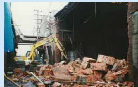
被災し解体中の玉津鑄造工場
