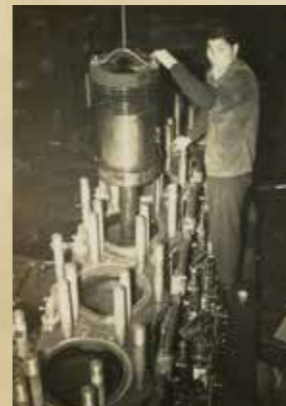
ピストン挿入作業 旧神戸工場 組立仕上工場 昭和20年代
