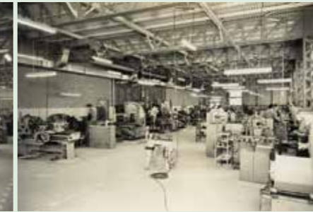
集塵機工場(明石工場内)
