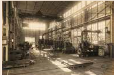
試運転場(本工場内)
