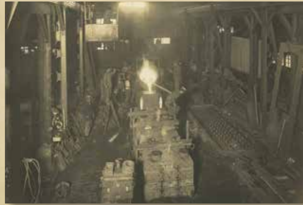
鑄込み作業 旧細田町 鑄造工場 1931(昭和6)年頃
