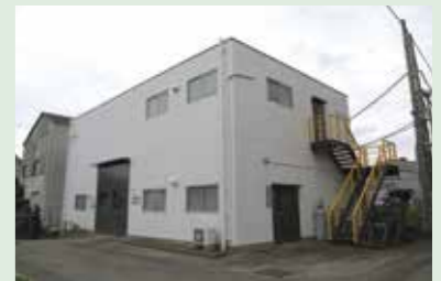
1980(昭和55)年、製品テストを行う研究実験棟が完成した。
