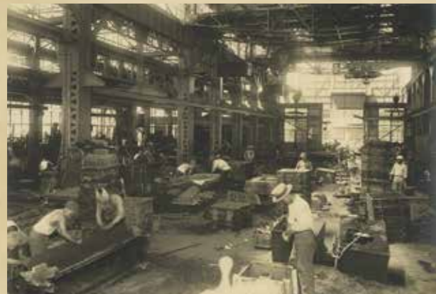
造型・型合わせ作業 旧神戸本社工場 鑄造工場 1937(昭和12)年頃
