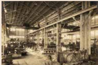
第二機械工場(本工場内)
