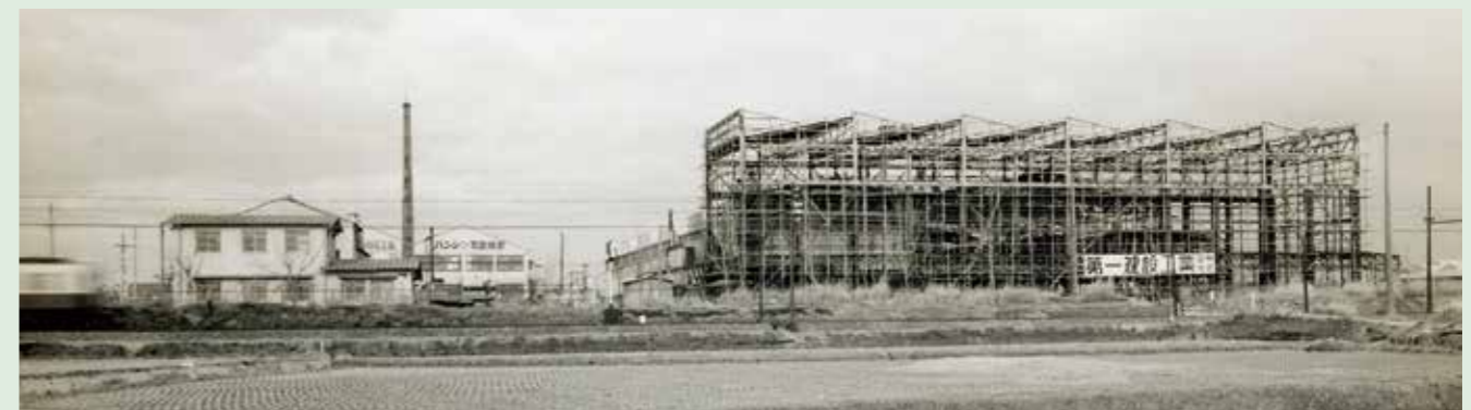
第6次設備拡充計画 明石工場に建築中の中速機関工場
