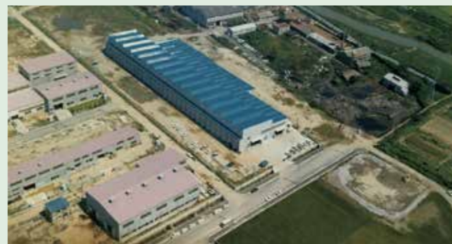
新機械工場(中央)と建設中の阪神鉄工団地(左側)
