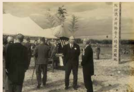
飾磨工場建設起工式
