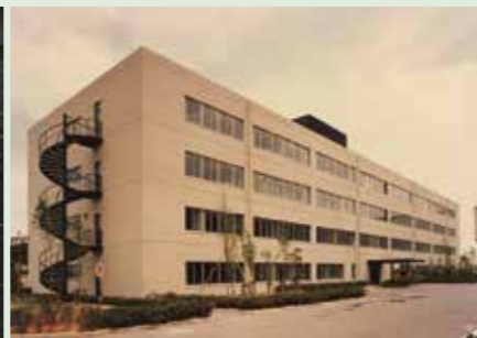
完成間もない本館事務棟
